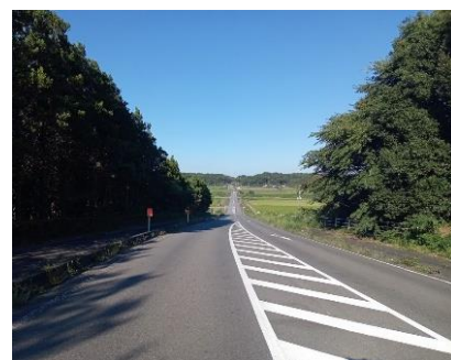
② クリーンプラザ前を抜け、ダウンヒルで加速。
